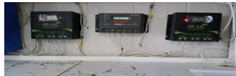
Рисунок 5 – Контроллеры серии SR-LG60A Series и PWM solar charge controller VS4548BN
