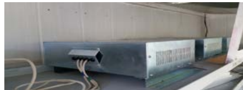
Рисунок 7 – ТЭНЫ для буферной нагрузки
