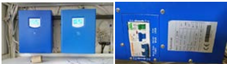
Рисунок 6 – Контроллеры для ветрогенератора серии Exmork ZKJ-B 3KW-48Vdc
